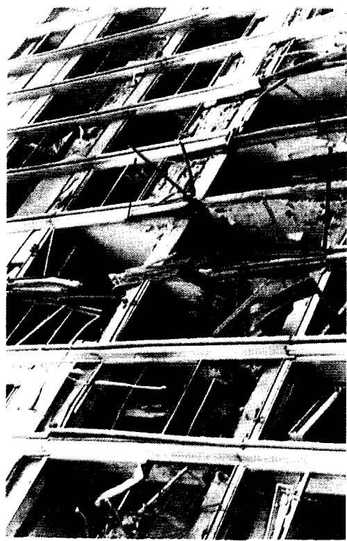
Наружный вид второго и третьего этажей бизнес-центра "Ушче", поврежденных в результате попадания ракеты
